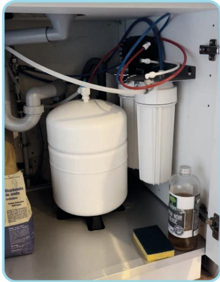
Méthode de filtration de l'eau au moyen d'une membrane ultra fine. Cette membrane permet uniquement le passage de l'eau tout en bloquant les substances indésirables. Il s'agit du système de filtration le plus performant de notre gamme.
